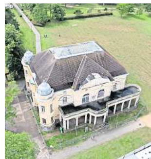
Die Villa Baltic ist ein zentrales Gebäude im Stadtteil Kühlungsborn West, in das Leben zurückkehren soll.
