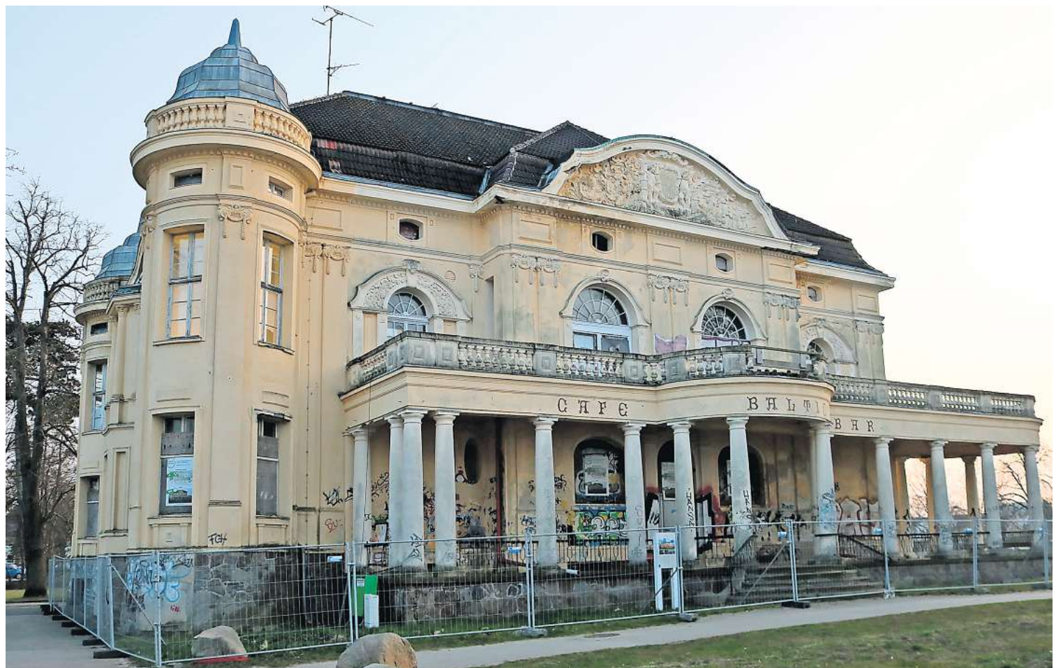
Die Villa Baltic steht seit Langem leer. Sie soll saniert werden. Außerdem ist ein Anbau mit Hotel und Gastronomie in Planung.
