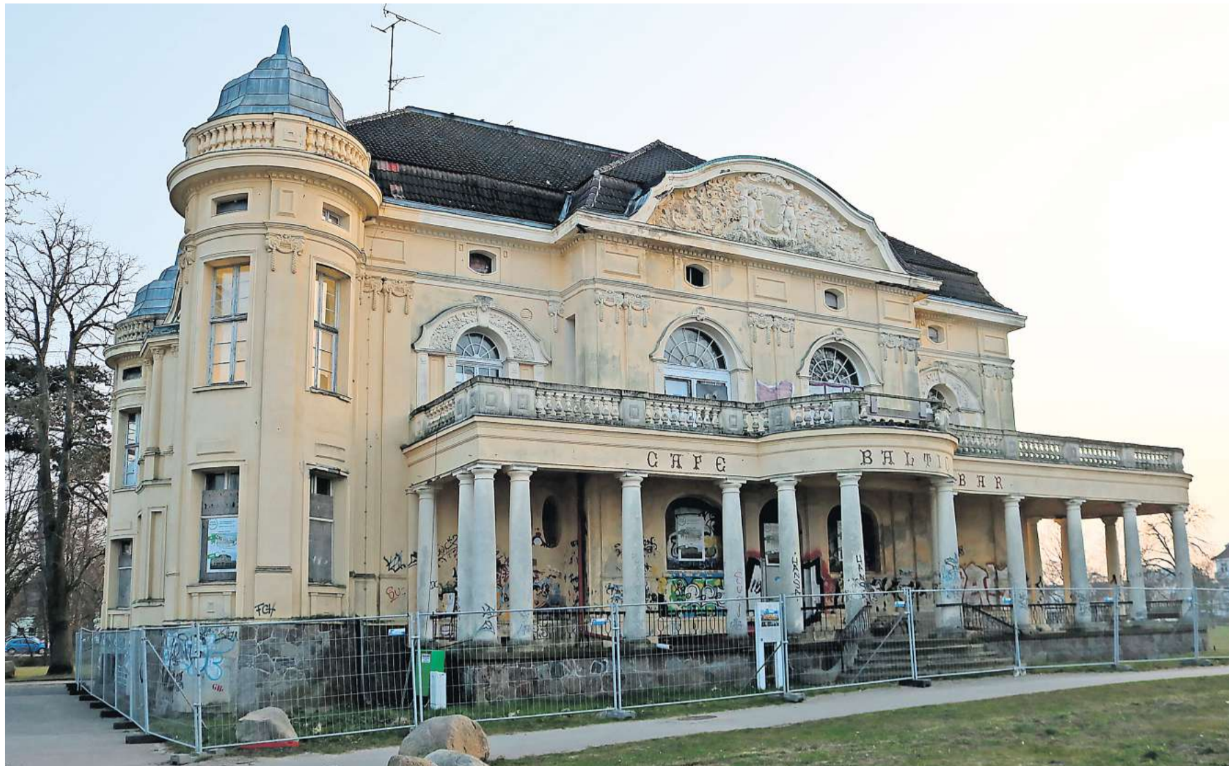
Die Villa Baltic in Kühlungsborn muss saniert werden.
