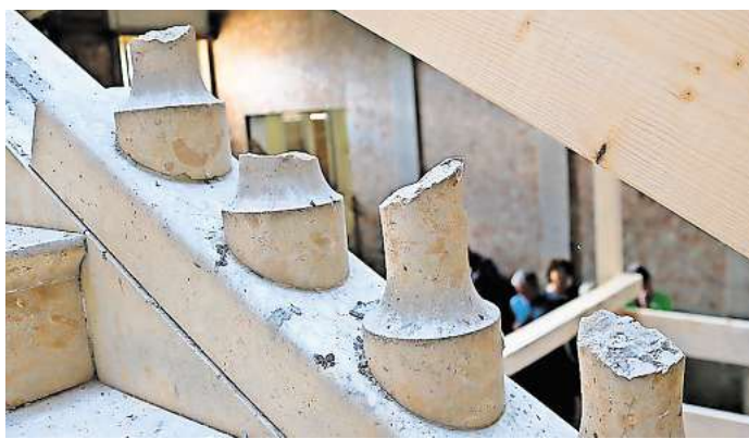
Seit über 35 Jahren ist die Villa Baltic an der Strandpromenade in Kühlungsborn West leerstehend. Alle bisherigen Sanierungsversuche durch Investoren und Eigentümer scheiterten. FOTO: FRANK SÖLLNER
