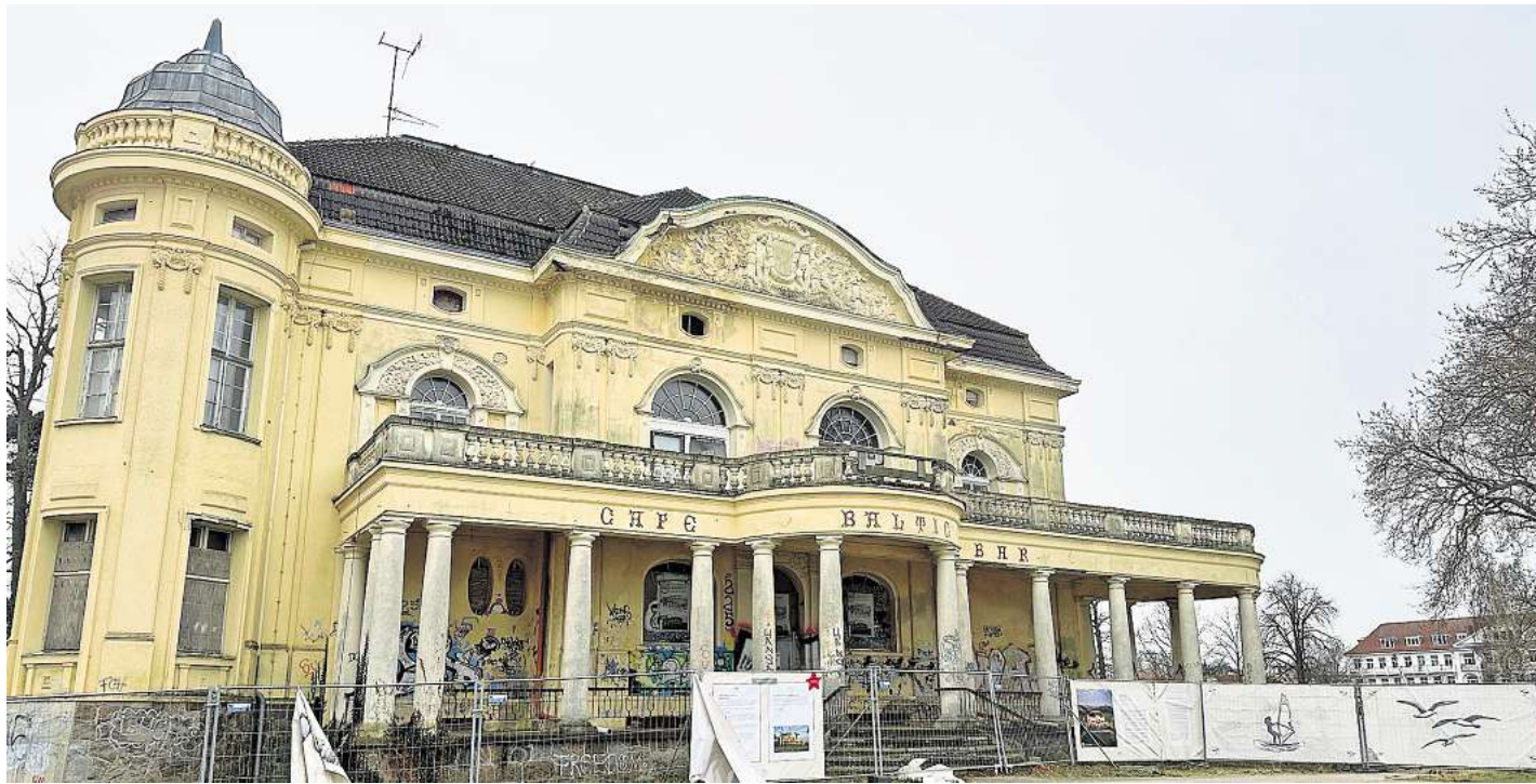
Die Zukunft der Villa Baltic wird seit Langem emotional diskutiert. Vor einigen Wochen wurden die Informationstafeln am Bauzaun vor dem Gebäude abgerissen. FOTO: PRIVAT
