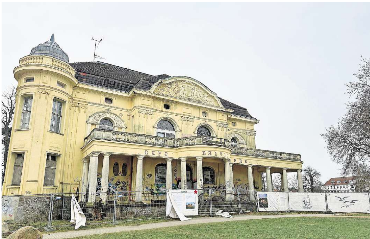
Die Zukunft der Villa Baltic wird seit langem emotional diskutiert. Gerade erst wurden die Informationstafeln am Bauzaun vor dem Gebäude abgerissen. FOTO: PRIVAT
